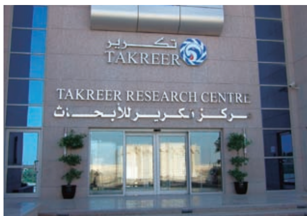
TRC 建屋 (3階建て) : アブダビ市の東郊外、2009年4月完成
