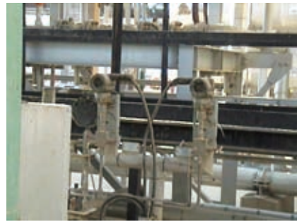
圧縮機周り改善前
