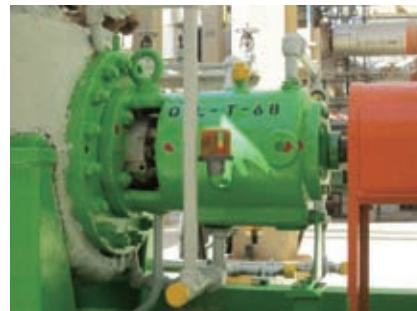
ポンプ改善後
