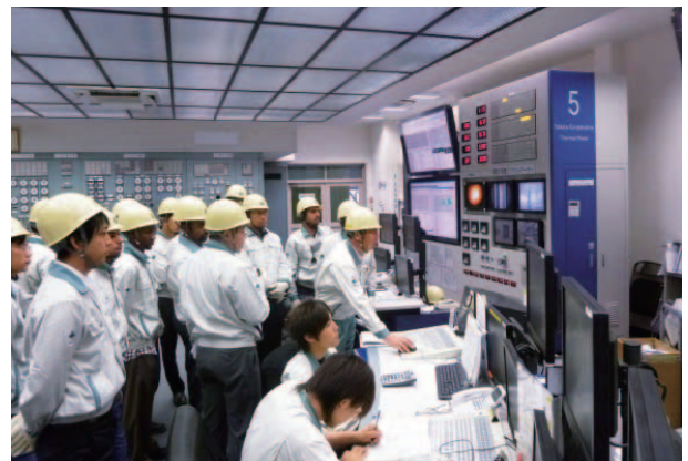
発電所の制御室における研修
